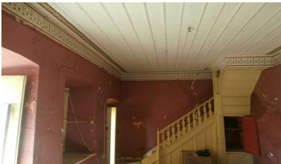
Φωτογραφία 2: Εσωτερικά του κτιρίου
