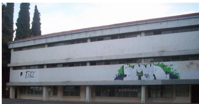
Εικόνα 5: Βόρεια-ανατολική όψη Λυκείου Άστρους
