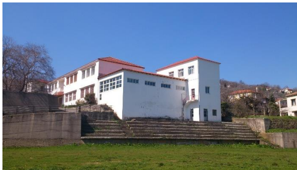
Εικόνα 20: Δυτική όψη κτιρίου
