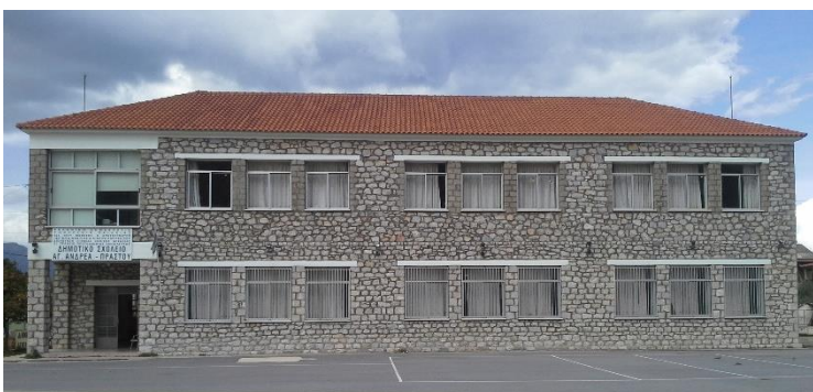
Εικόνα 25: Νότια όψη Γυμνάσιο Λύκειο Αγίου Ανδρέα
