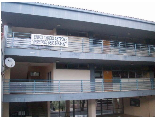
Εικόνα 4: Νοτιοδυτική όψη Λυκείου Άστρους
