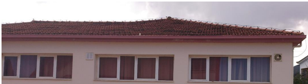
Εικόνα 15: Οροφή σκυροδέματος κάτω από μη θερμομονωμένη στέγη
