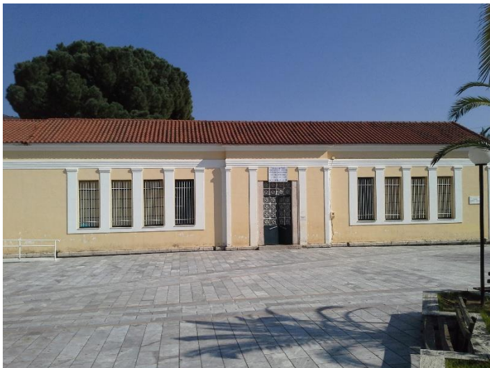
Εικόνα 28: Δυτική όψη κτιρίου
